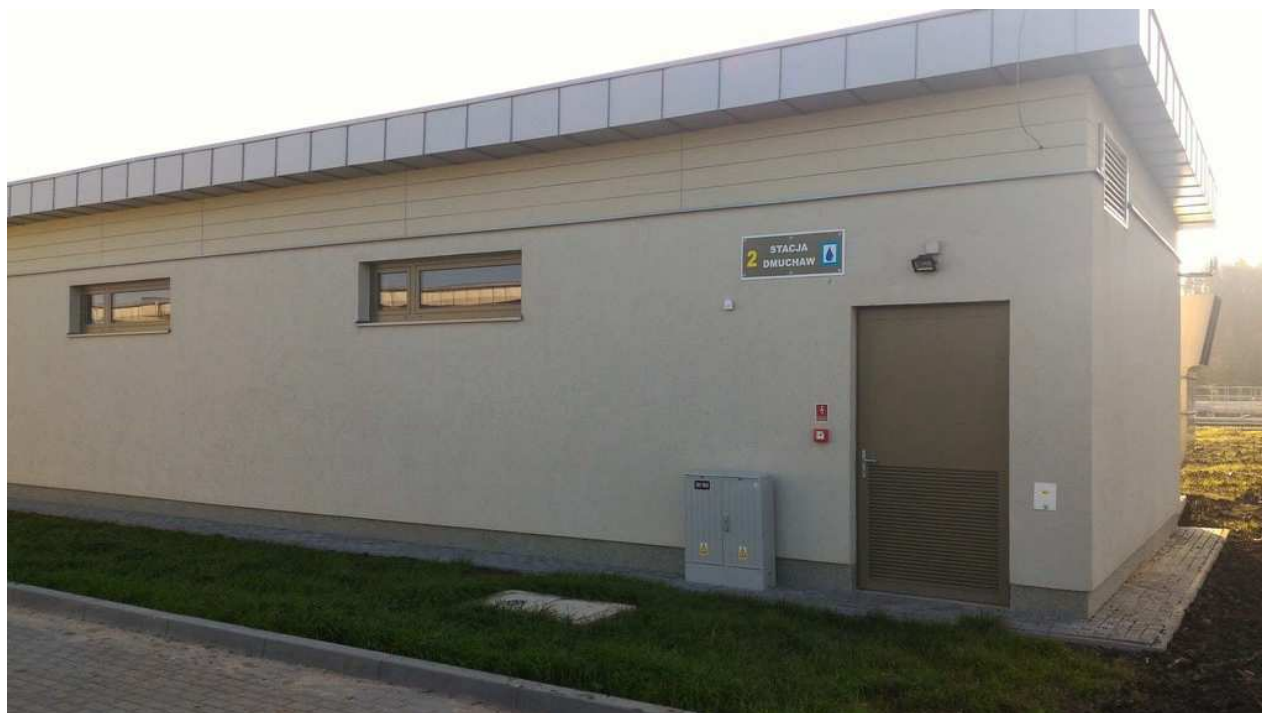
Obiekt nr 2 – budynek dmuchaw.
